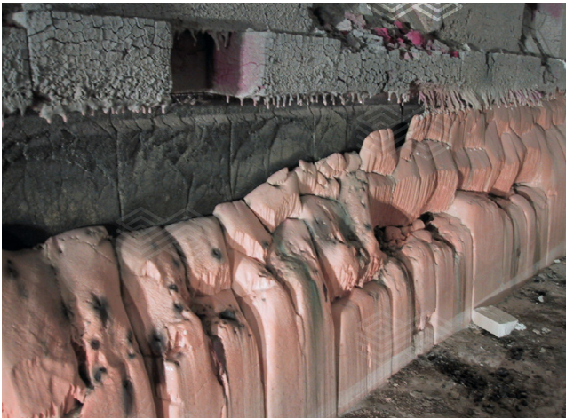
DURITAL CR30ZPRPHD Nachsetzplatten nach drei Jahren / DURITAL CR30ZPRPHD overcoating tiles after three years
